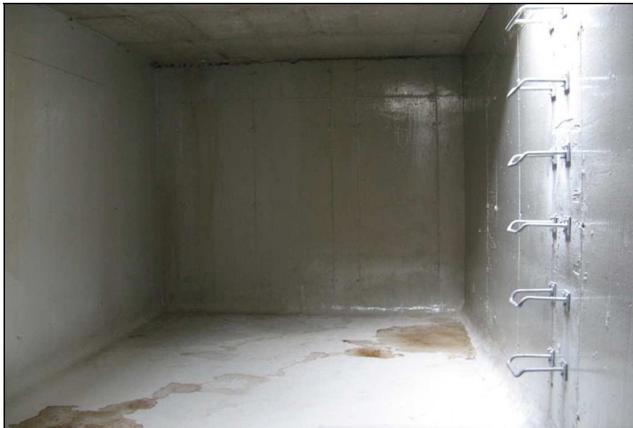
Foto 2. Vista interior del citado depósito
